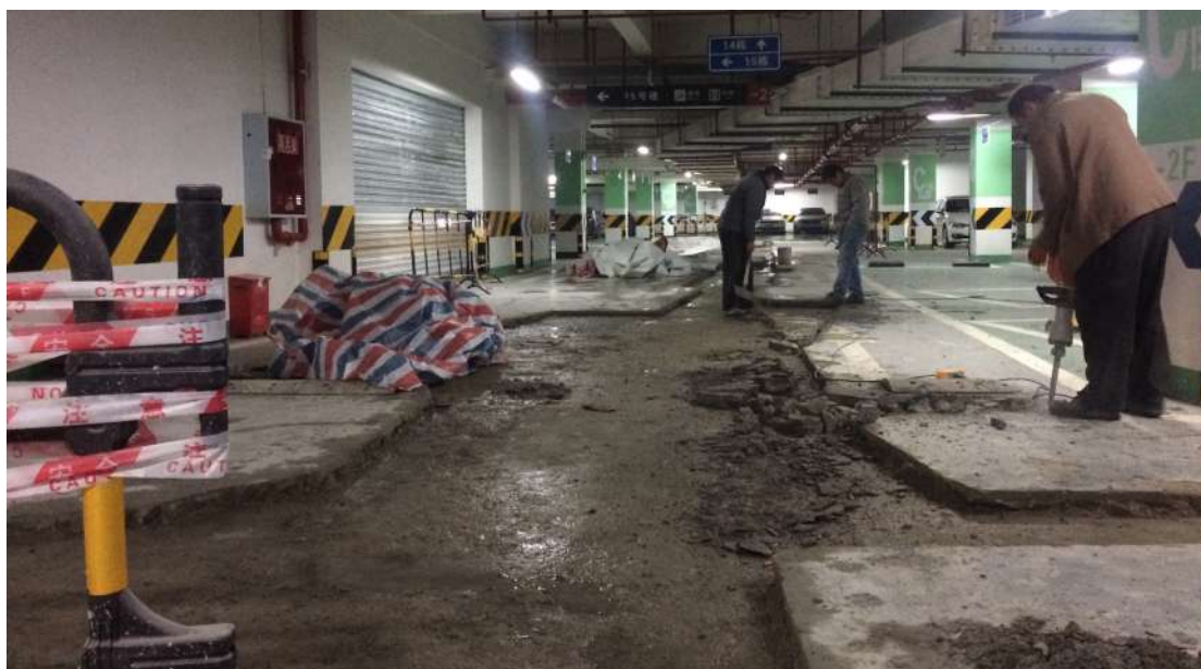
世茂玉锦湾地下车库二层一处渗水处正在施工修整
